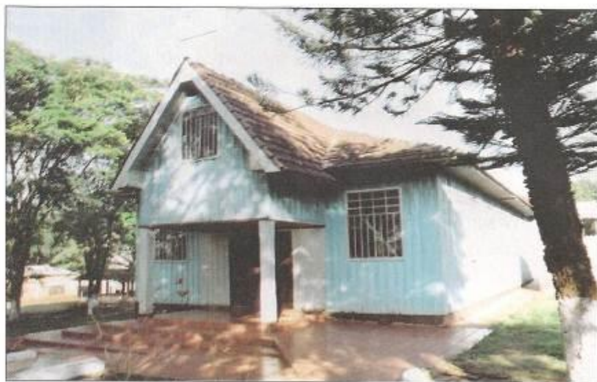
Capela Colônia Santo Inácio - julho 2007.
