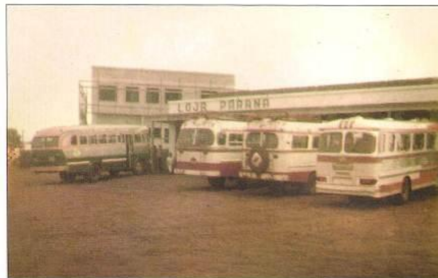
Rodoviária velha e os ônibus do Expresso Maringá. Ao fundo, a construção da atual Prefeitura - 1968.
