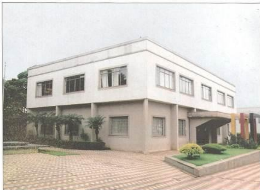
Atual prédio da Prefeitura Municipal de Ubitatã - 2006.
