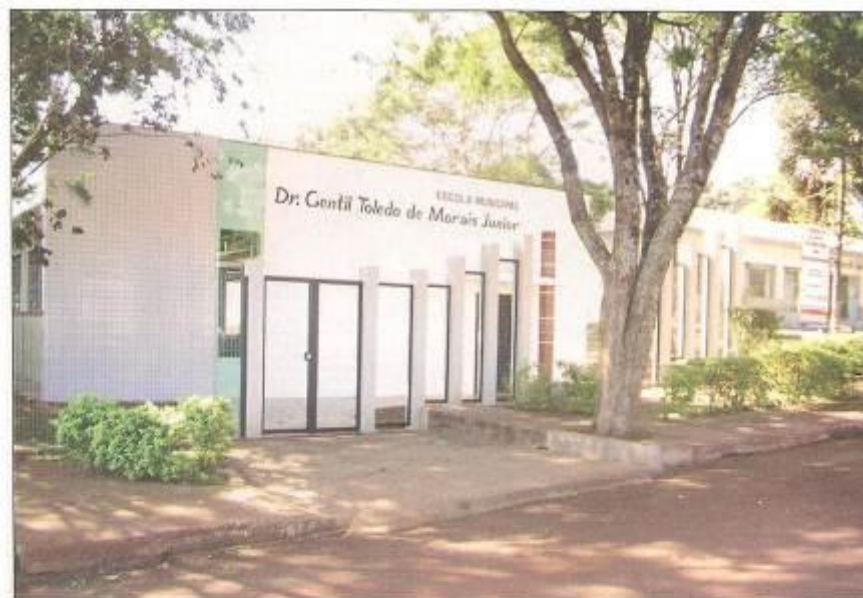
A Escola Municipal Dr. Gentil Toledo de Moraes Júnior veio para suprir a necessidade dos moradores do Conjunto Habitacional Boa Vista - 2007.
