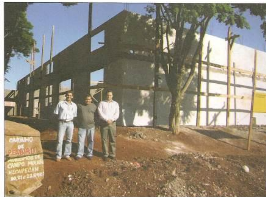
Início das obras do Salão Comunitário da Comunidade São João - 2008
