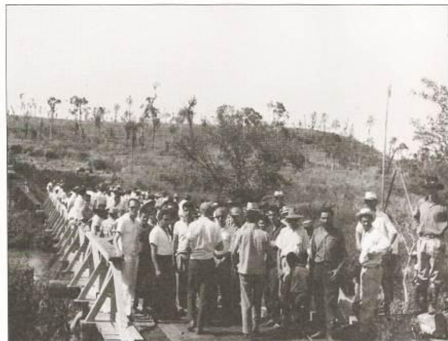
A ponte sobre o rio Ronquita foi entregue ao tráfego em 1963.
