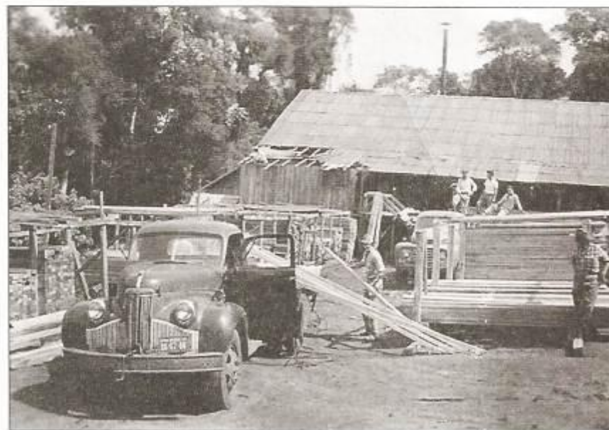
Serraria Sete de Setembro, a segunda instalada em Ubiratã - 1957,
