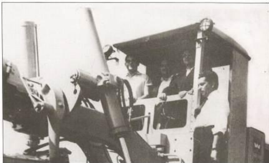
A arrancada: Alberoni (em primeiro plano) e a primeira motoniveladora adquirida pela Prefeitura de Ubiratã - 1962.
