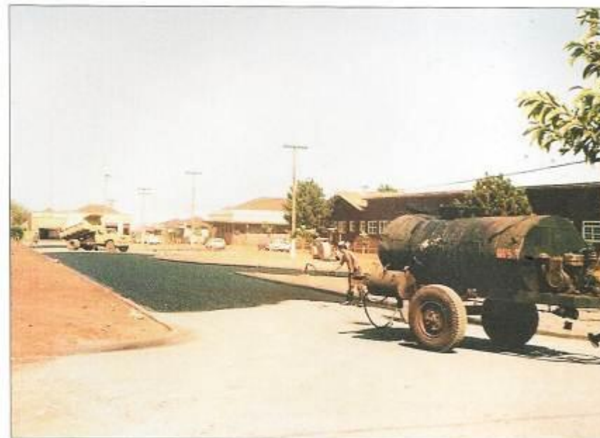
Início do asfaltamento em frente a Igreja Matriz e o Colégio Santo Antônio - 1978.
