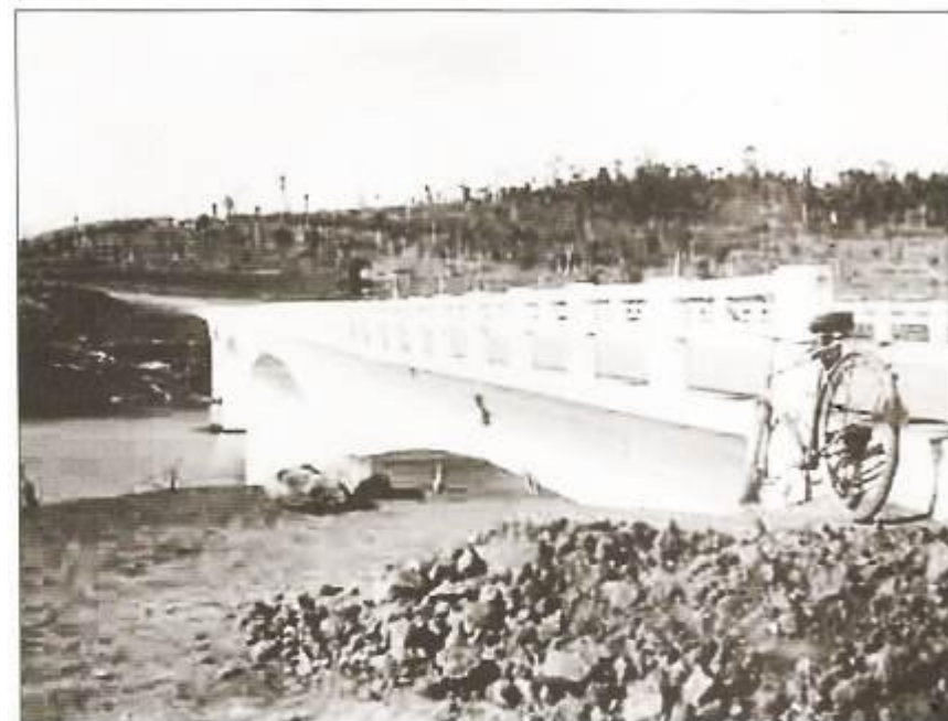
A empresa Velloso & Camargo construiu a ponte sobre o Rio Piquiri - 1966.
