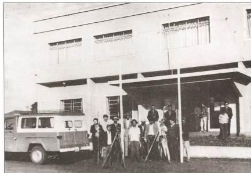
Nivelamento da cidade para a implantação da rede de água - 1971.
