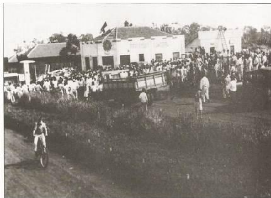
Festa na chegada da primeira motoniveladora em frente à antiga Prefeitura na Avenida Yolanda Loureiro de Carvalho, esquina com a rua Floriano Peixoto no ano de 1962.
