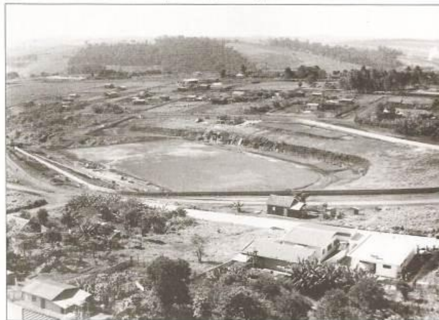
Estádio Municipal Claudinão em obras: aqui teve início a cidade de Ubiratã com o primeiro acampamento em 24 de agosto de 1954.
