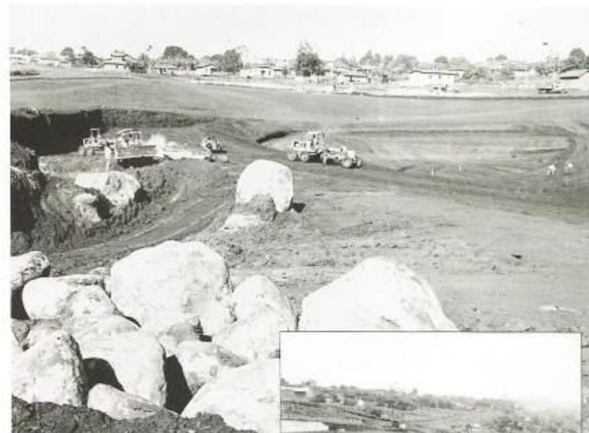
Início da terraplenagem para a construção do Estádio Claudinão - 1974.
