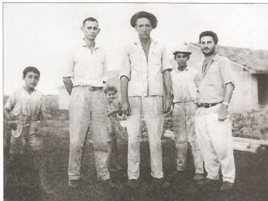
Luiz Carlos Gomes, Herbert Fuerbringer e Vilder Bordin na construção da ponte do Rio Carajá - 1963.
