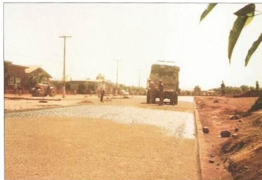
Asfaltamento em frente a Igreja Matriz - 1978.
