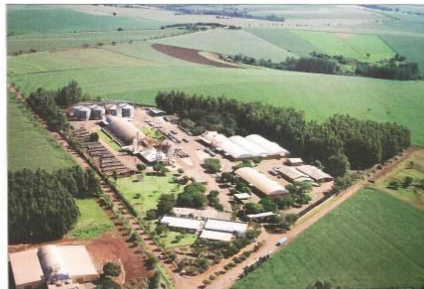
Coagru, uma construção árdua e grande vitória dos produtores - 2007.
