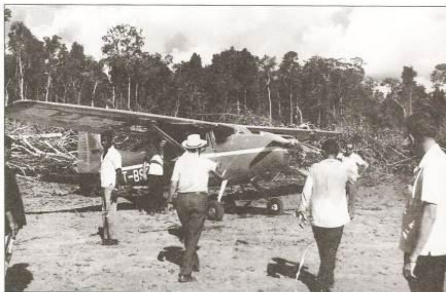
Avião pousa no campo aberto no centro da vila de Ubitatã - 1956. Neste local atualmente está o Banco do Brasil e a Prefeitura.
